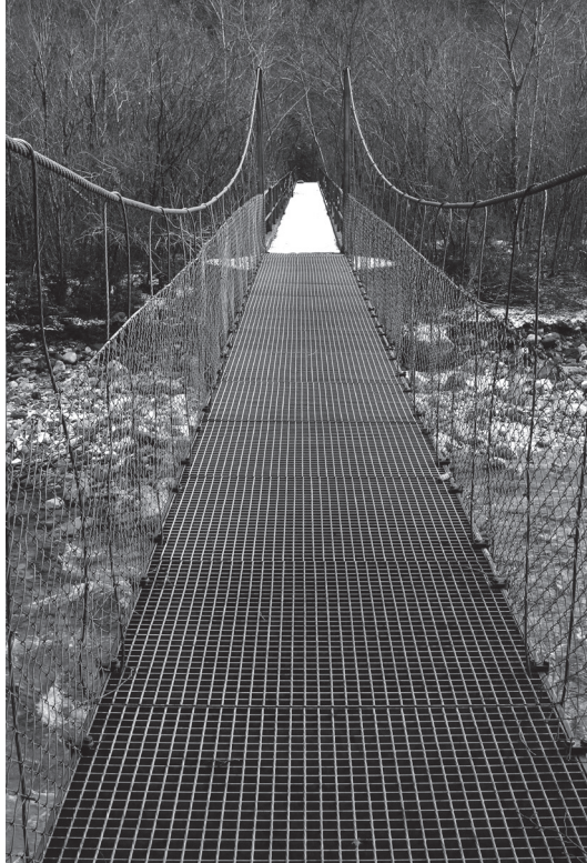
Hängebrücke bei Salino
